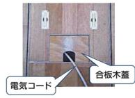
ピット小蓋の通線用フタはピット 内に収納して、電気コードはコン セントに挿し、通線用穴部分に合 板木蓋をかぶせてください。
